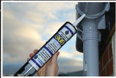
Reparerer utette takrenner umiddelbart
